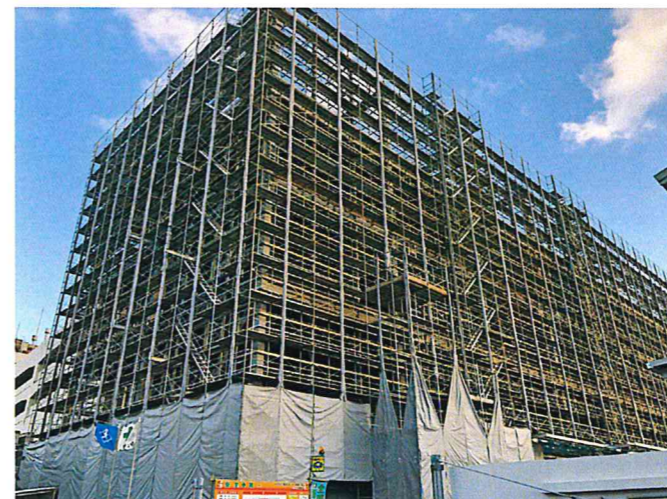
鉄骨建方完了時
